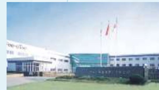
杭州大和热磁电子有限公司一工厂 Hangzhou Dahe Thermo-Magnetics Co.,Ltd ( 1st factory | )
