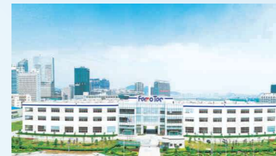
杭州大和热磁电子有限公司二工厂 Hangzhou Dahe Thermo-Magnetics Co.,Ltd ( 2nd factory | )
